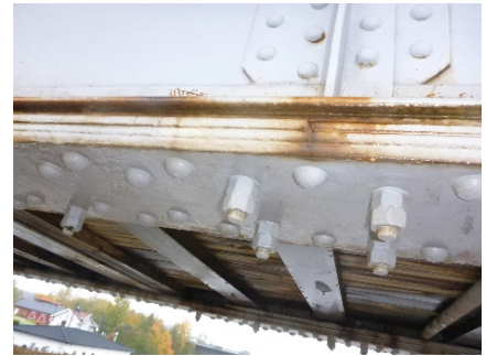
Typisk overflate hvor ET utføres
